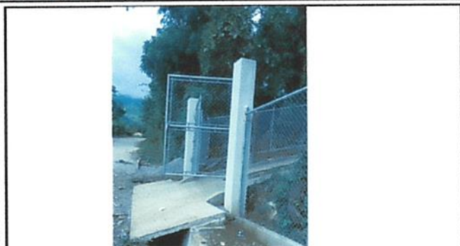
Foto 1: cuneta con rampa de acceso y portón instalados
